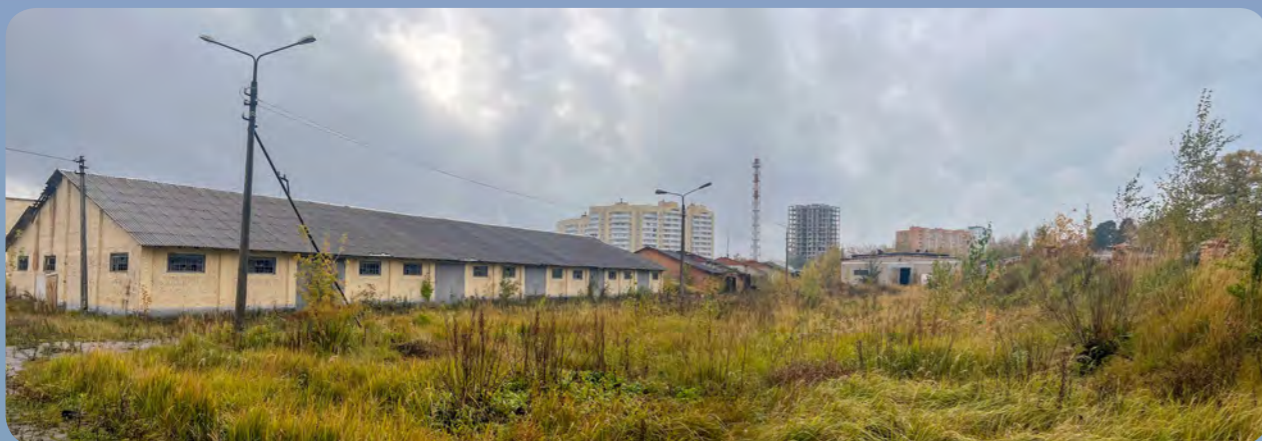
Имущественный комплекс под гостиничный объект в Звенигороде
