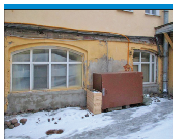
Нежилое помещение пер. Гривцова, д. 1/64, лит. В, пом. 13-Н
